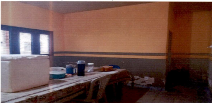
COZINHA – áreas de cocção e refeitório com toda a estrutura comprometida (piso, forro e paredes) por umidade, fungos e mofo. Sem condições de funcionamento.
