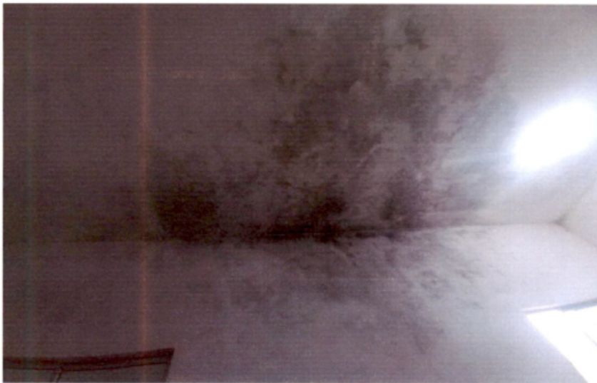
Posto de Enfermagem – sinais de abandono. Superfícies do forro e paredes muito comprometidos por extensas áreas com mofo/fungos e umidade,
